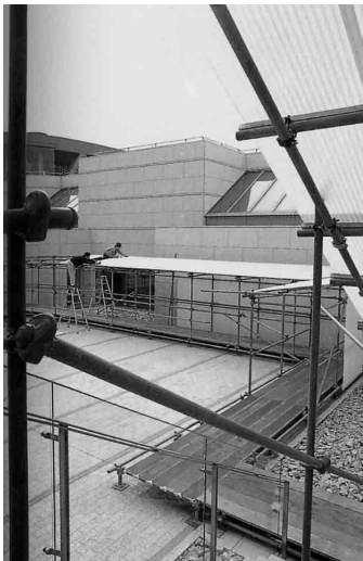
写真1 キャットウォーク 川俣正 1994 東京都現代美術館のサンクンガーデン他にしつらえられた工事中仮設足場の回廊
